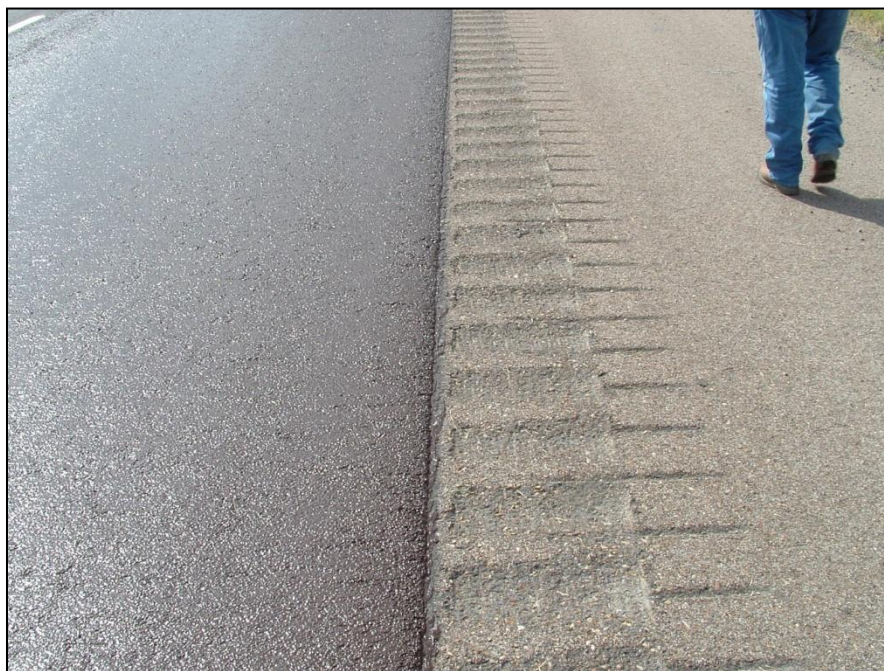
Figura 7.13: Micropavimento terminado lado izquierdo
