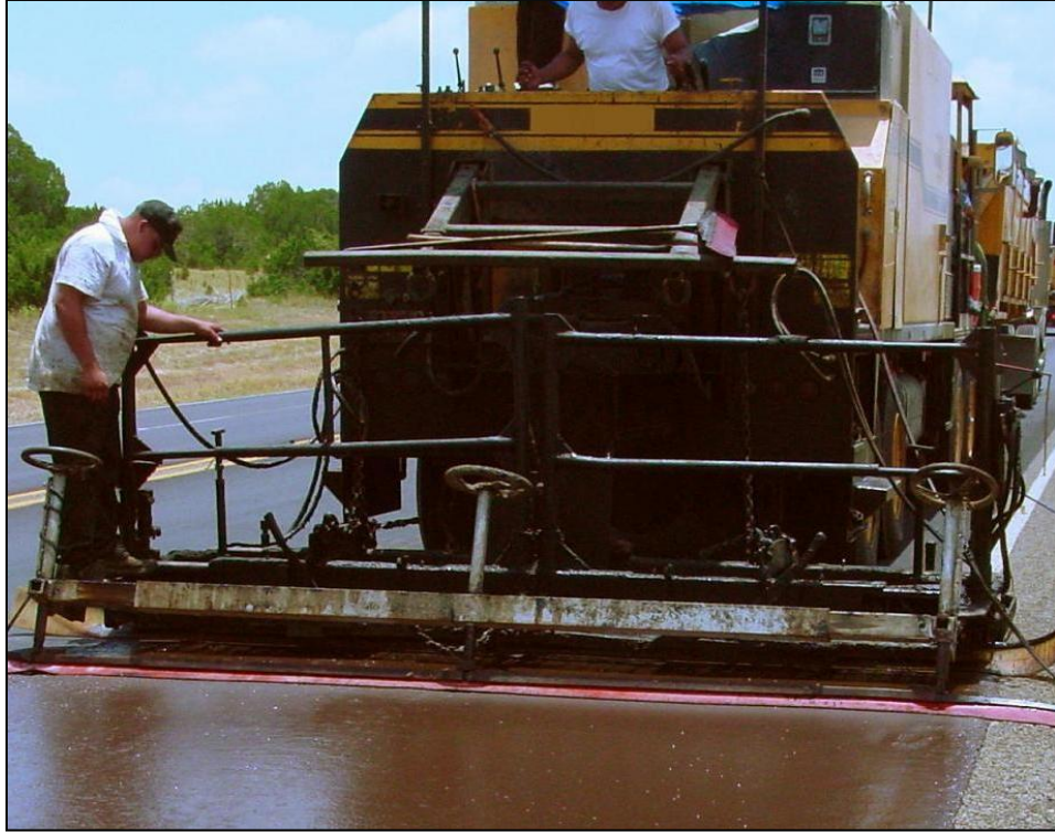
Figura 7.14: Caja esparcidora con banda de caucho
