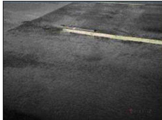
Figura 7.17: junta transversal de alta calidad y junta transversal de baja calidad.
