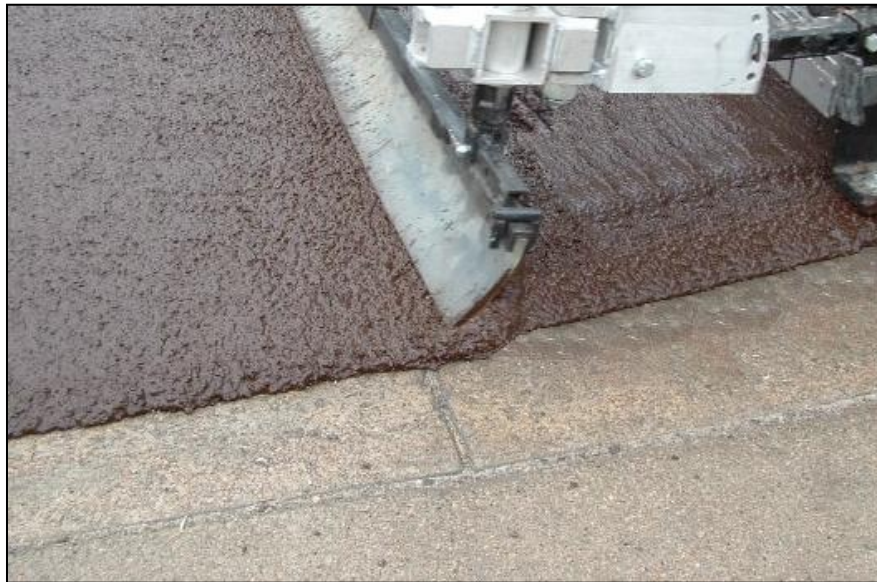
Figura 7.24: Colocación de micropavimento sobre pavimento rígido.
