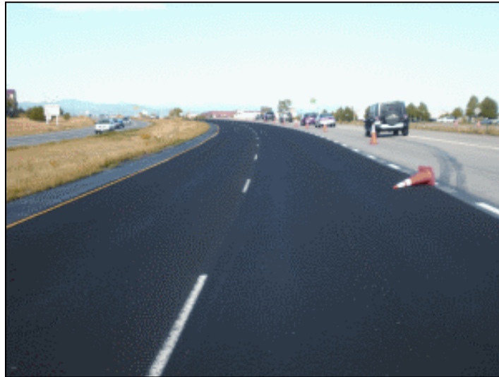
Figura 2.1: Vía con Micropavimento
