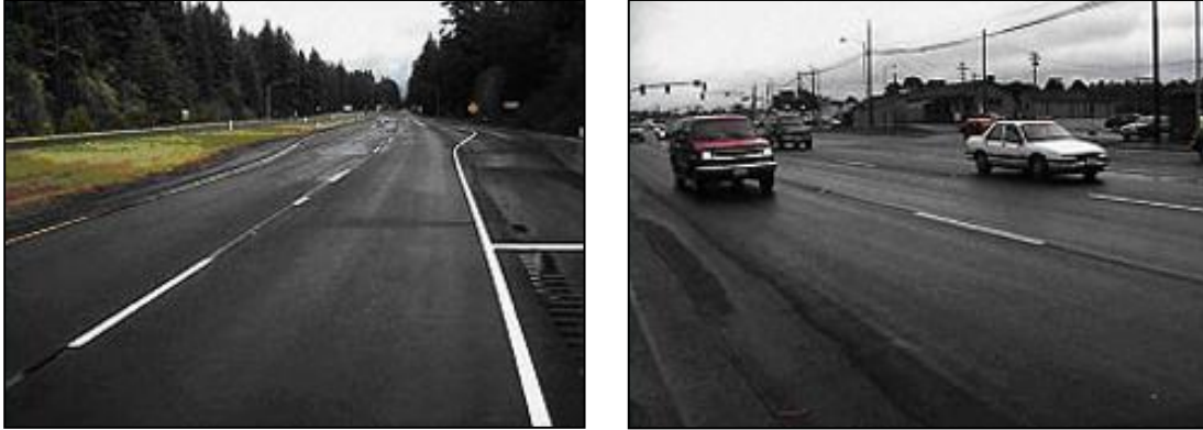
Figura 7.18: Bordes de alta calidad y bordes de baja calidad.
