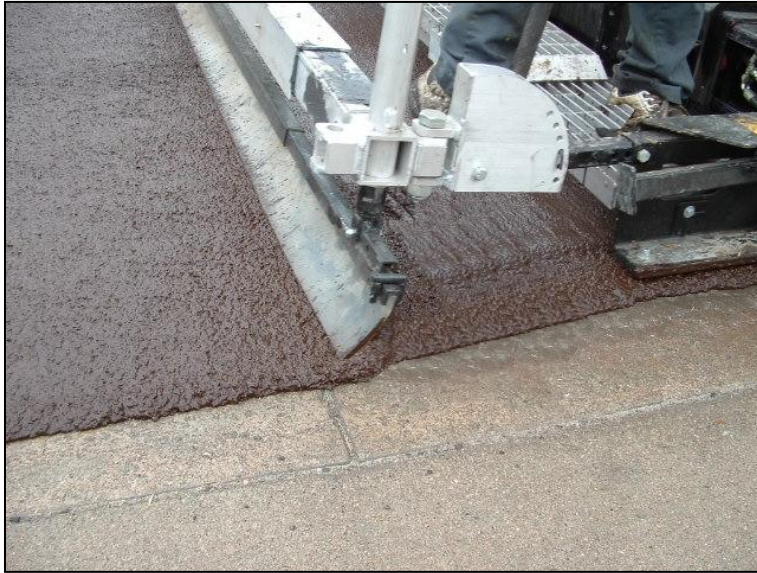
Figura 7.12: Colocación de micropavimento
