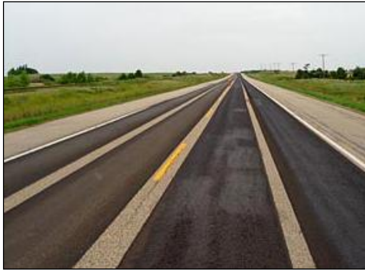
Figura 7.20: Recuperación de ahuellamiento.
