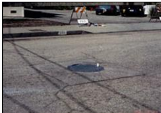
Figura 7.6: Protección de alcantarillas.
