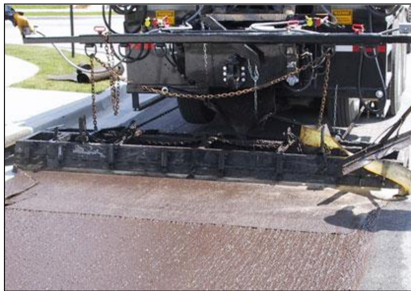
Figura 7.16: Caja esparcidora con tela de arrastre.
