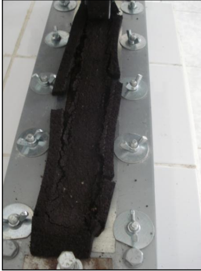
Figura 5.25: Muestra dañada antes de los 1000 ciclos.
