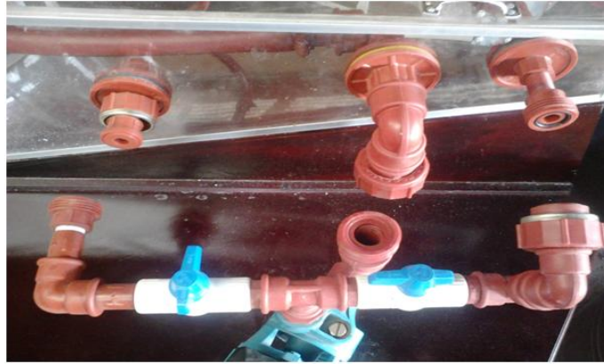
Figura 3.14: Perforación de los tanques
