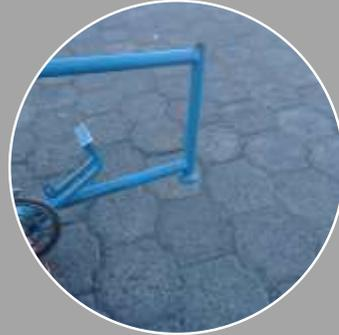
Modificación del telescopio del mismo el cual se cortó el original y se soldó un tubo de una pulgada este servirá de eje fijo para darle dirección al triciclo de carga
