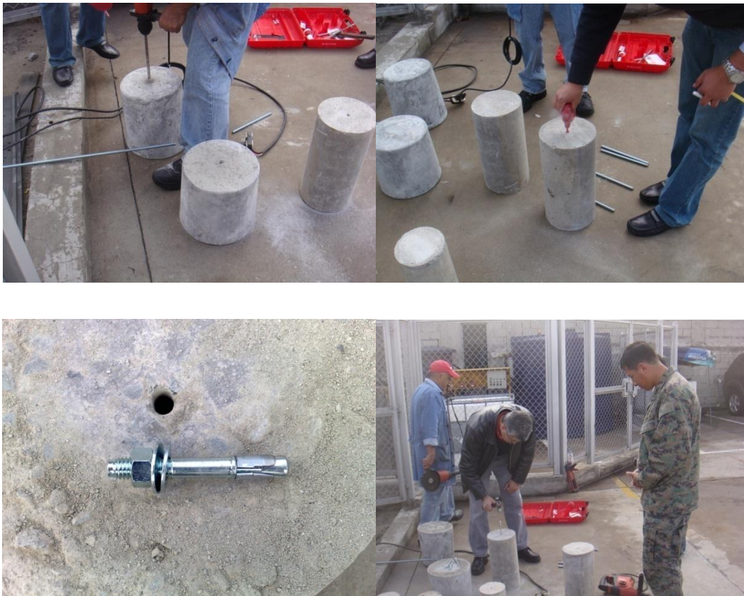
Figura 4.4 Elaboración de Probetas para Sistemas de Anclaje Postinstalados de torque controlado en cuña.
