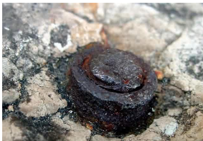
Figura 3.29 Aseguramiento de anclaje expuesto a ambientes agresivos.
