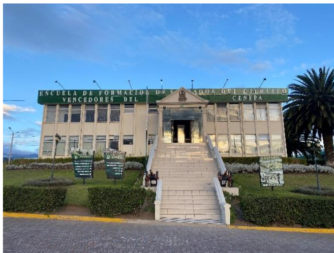
Vista Frontal Edificio Central CENEPA
