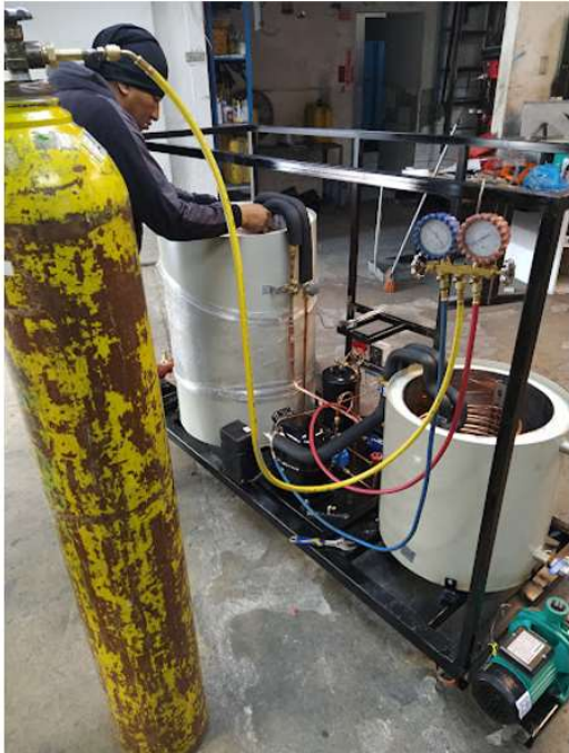
Presurización y revisión de fugas
