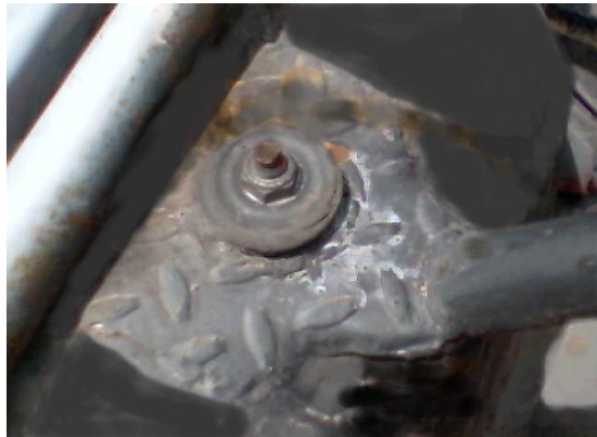
Fig. 71. Reforzamiento en torres.
