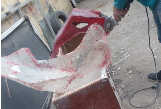
Quitar los excedentes de fibra de vidrio con una amoladora
