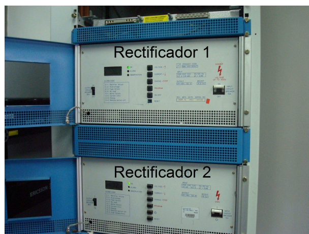
Figura 2.8: Rectificador Ericsson TDMA - CDMA
