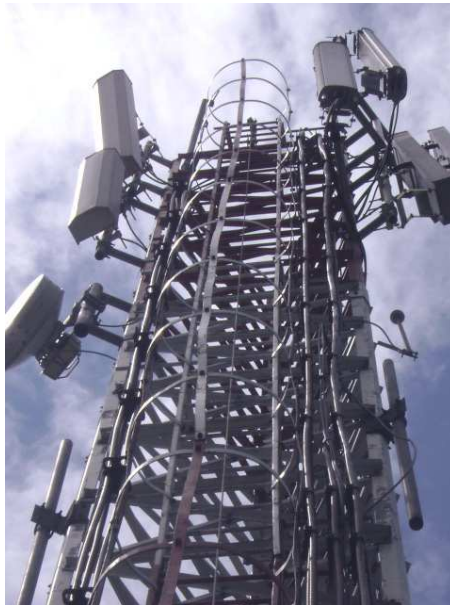
Figura 2.12: Sistema de antenas celulares
