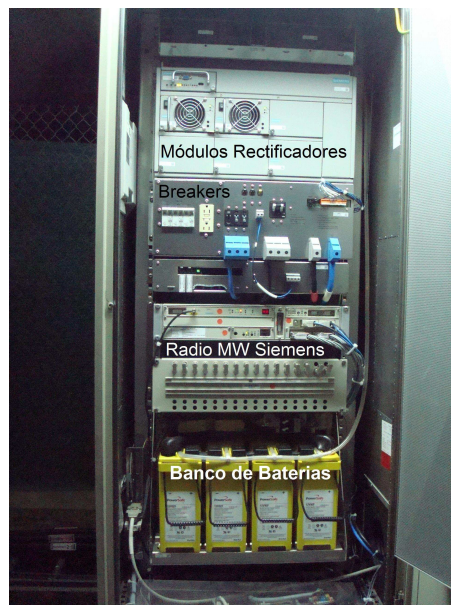
Figura 2.18: Rectificador y radioenlace
