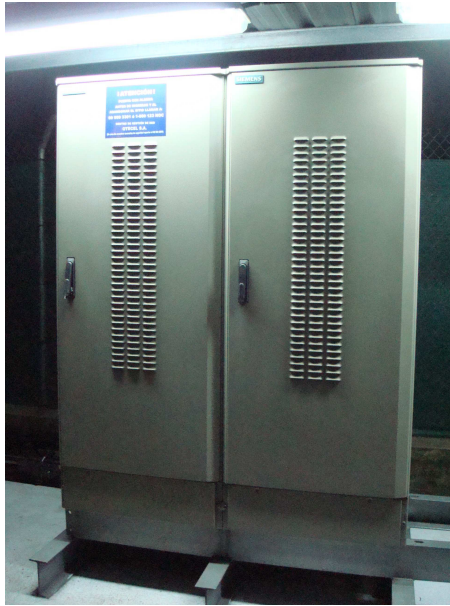
Figura 2.17: BTS Siemens GSM
