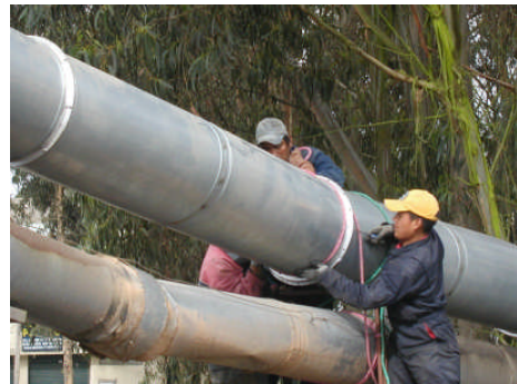
Figura 3-4 Armado de tramos.
