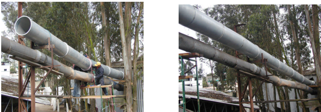
Figura 3-3 Montaje tubería de baja presión.
