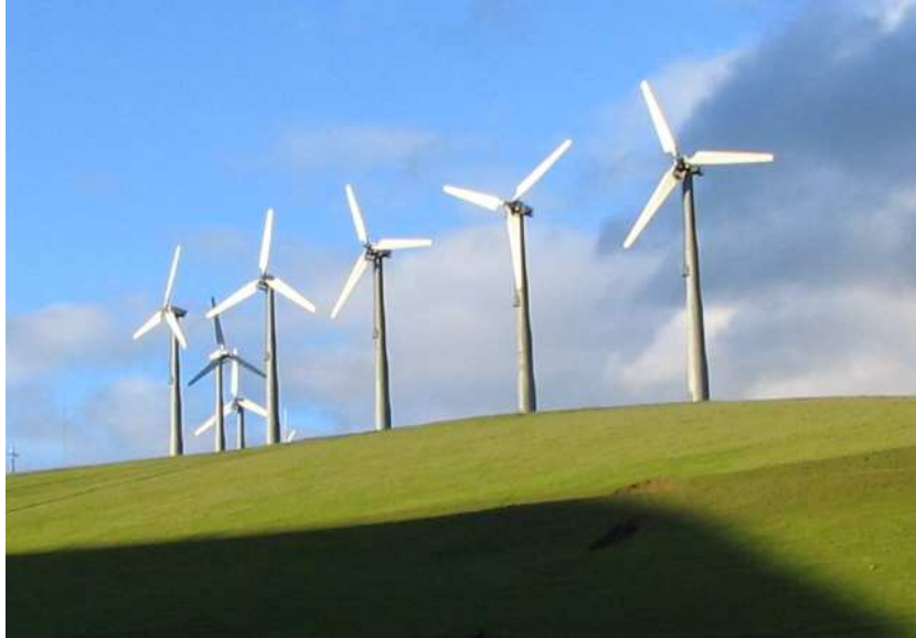
Figura 1.24 Una central eólica para generación de electricidad. 27
