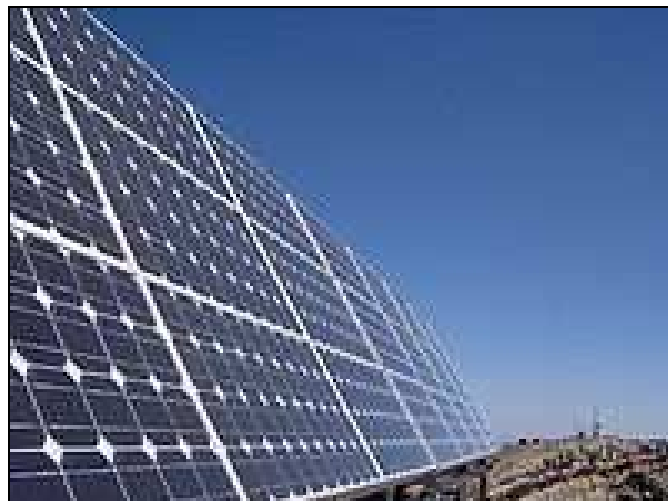
Figura 1.23 Paneles solares que convierten directamente la energía luminosa en energía eléctrica. 26
