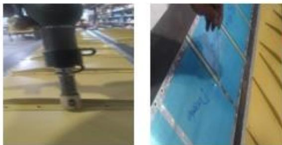
Una vez realizado el back riveting una la piel TOPSKIN con el borde del alerón juntándola con clecos #40 para posterior mente ayuda de un compañero remachamos con remaches AN426AD3-3.5 uniendo así el borde con la piel del alerón para posteriormente sujetar la piel BOTTOM SKIN y con ayuda de un Bucking Bar largo remacharemos la piel BOTTOM SKIN usando remaches AN426AD3-3,5.
