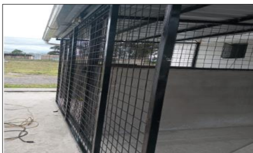
Instalación completa de la puerta corrediza del almacenamiento
