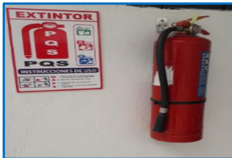
Instalación del extintor
