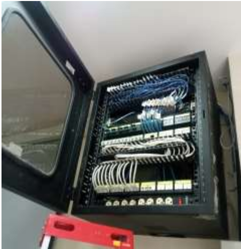
Colocación de cable vertical
