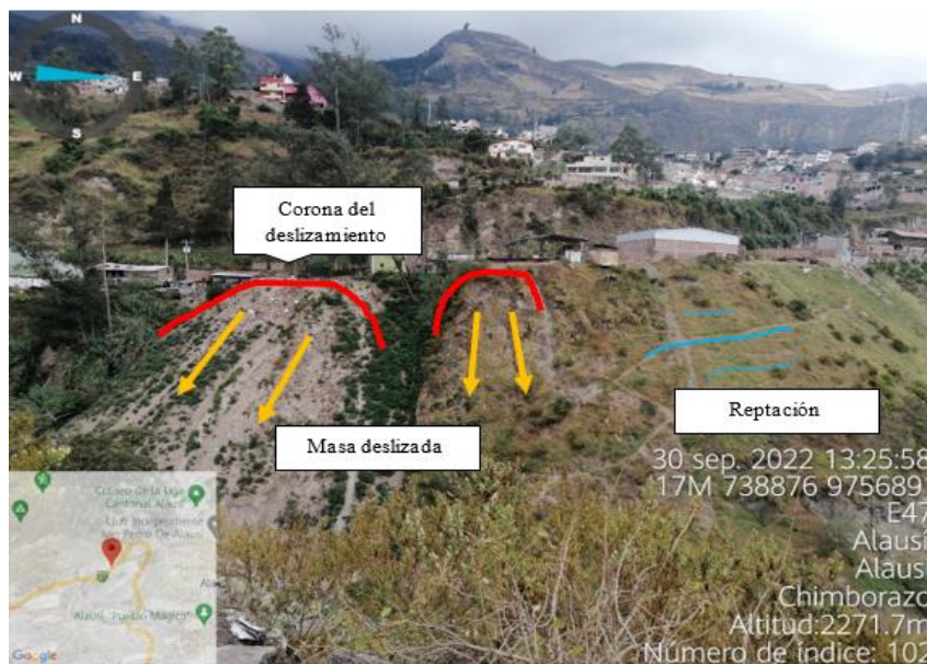
Deslizamientos observados en el punto 9
