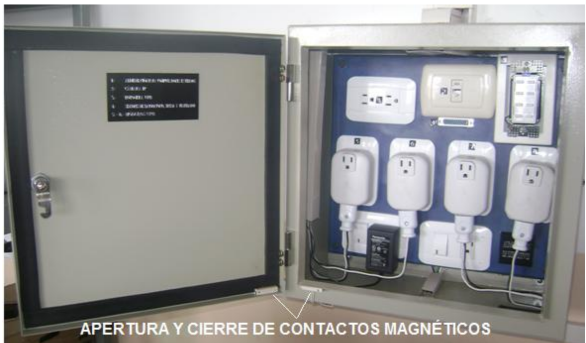
Figura 4.10 Pruebas de los contactos magnéticos en la puerta del módulo de domótica
