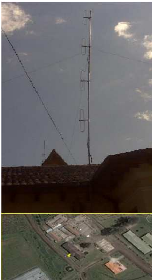
Figura 3.43. Ubicación final del arreglo de cuatro dipolos doblados en la Prevención Central de la Hacienda “El Prado”
