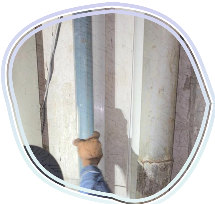
Reconocimiento de tuberías
