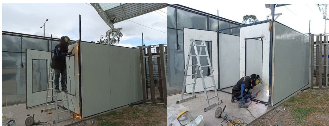
Soldadura de las bisagras para puertas
