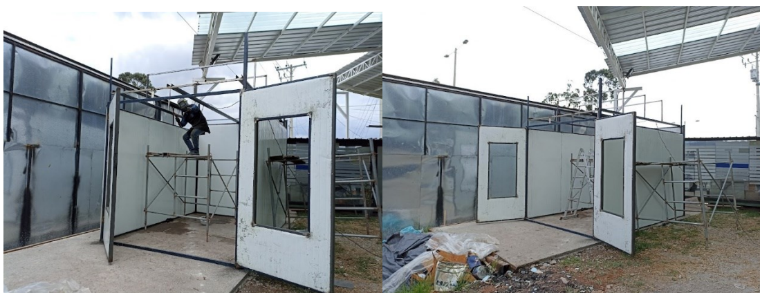
Fijación de la estructura para soporte de paneles de iluminación
