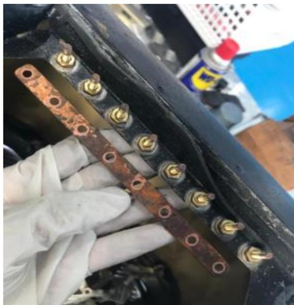
*Nota.* La figura muestra la barra en donde se conectan los terminales a tierra en mal estado.
