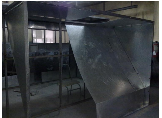
Construcción del cuarto de succión
