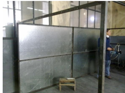
Ensamble de las planchas a los perfiles
