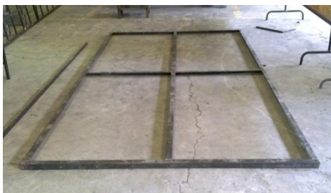
Construcción del techo de la cabina
