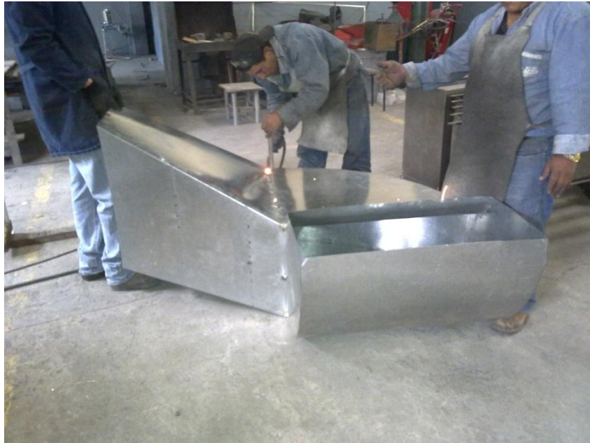
Construcción del ducto de salida
