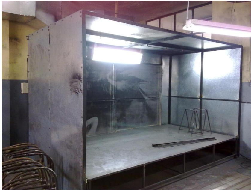
Luminarias de la cabina
