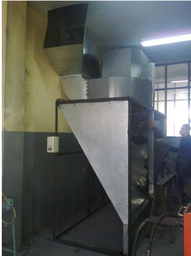
Detección de fugas del cuarto de succión
