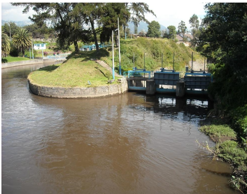
Fotografía N°2: Sector de la Bocatoma en San Rafael (el agua del Río San Pedro es canalizada para llevarla al reservorio de Guangopolo)
