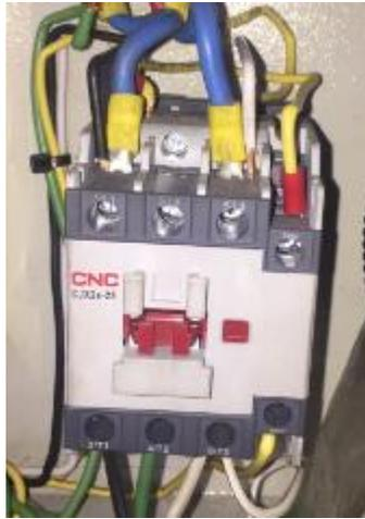
*Nota.* Contactor CNC, modelo CJX2s de 25A, voltaje de bobina 220V y 7.5 HP.
