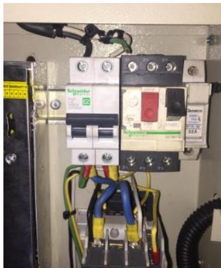
*Nota.* El cable solido de color negro es la línea de 220V AC que ingresa a la entrada del breaker, mientras que el cable solido de color blanco es el neutro que ingresa a la otra entrada del breaker, de las salidas salen 2 cables solidos de color azul hacia el contactor, del cual saldrán 2 cables negro y blanco hacia el motor monofásico.
