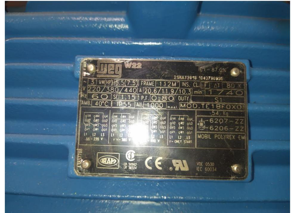
Nota. En la figura 21 se observa los parámetros eléctricos del motor eléctrico 7,5 HP con freno,
