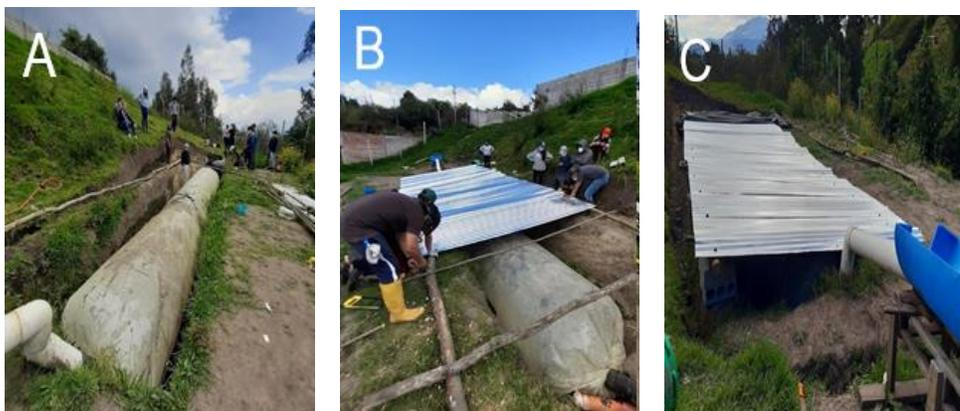
*Nota.* A), B) y C) Construcción de la cubierta del biodigestor con ayuda de estudiantes de vinculación de la ESPE. Fotografías tomadas por la autora.
