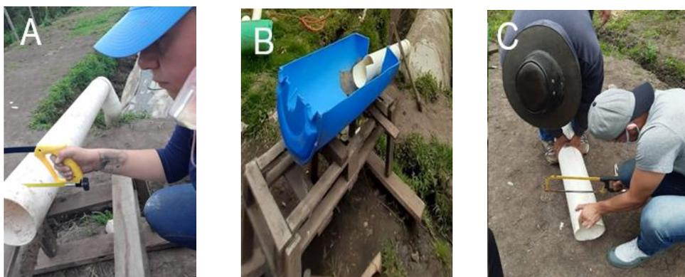
*Nota.* A) y B) Adaptación de la entrada. C) Adaptación de la salida del biodigestor con tuberías y codos de PVC. Fotografías tomadas por la autora.
