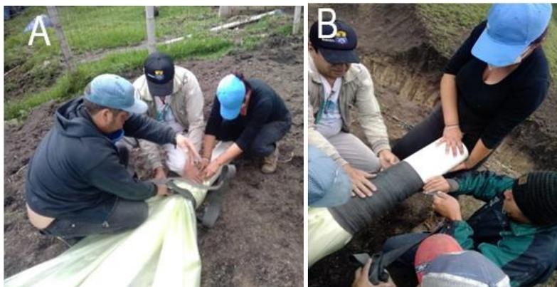
*Nota.* A) Colocación de tubería dentro de la bolsa del biodigestor. B) Amarre de los extremos con caucho de neumáticos. Fotografías tomadas por la autora.
