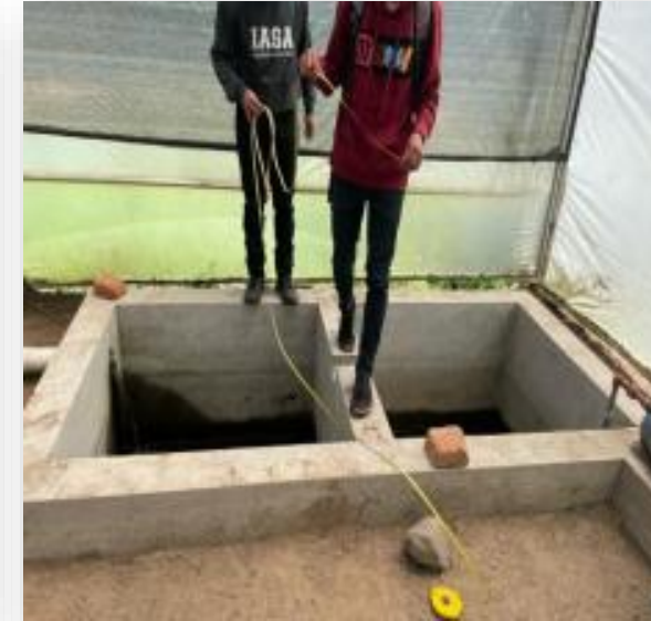
Sistema de Recirculación
