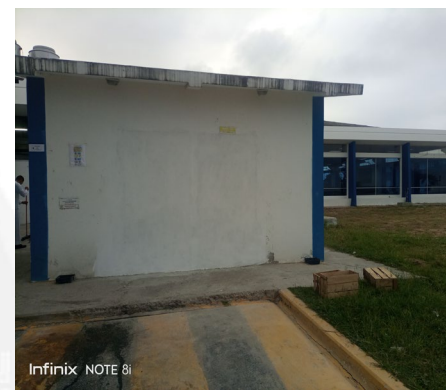
Mejoramiento del centro de acopio primario
