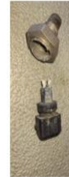
Reemplazo de sensor de temperatura.
