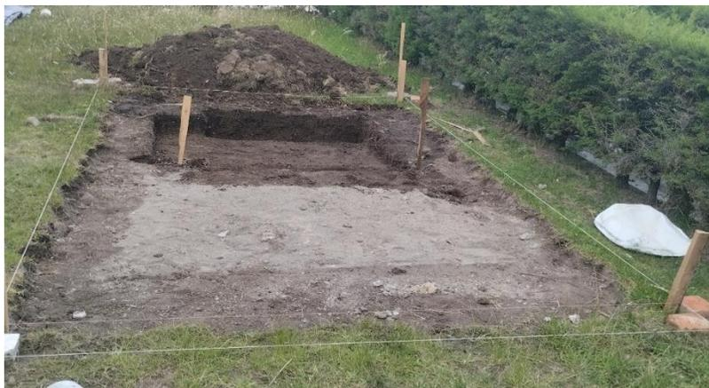
*Nota.* La fotografía detalla la colocación de estacas para limitar el área de construcción, y posteriormente se nivela el terreno para una correcta implantación. Autoría propia
