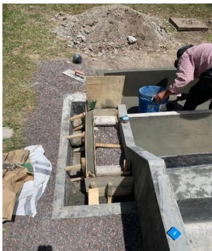
*Nota.* Se observa la construcción del canal de recolección del agua captada a través de la rejilla tipo Coanda. Autoría propia
