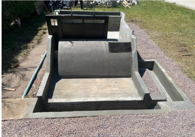
*Nota.* Se observa la colocación de piedra chispa alrededor del modelo y colocación de la malla tipo Coanda. Autoría propia
