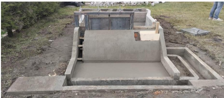
*Nota.* Se muestra la obra gris en el proceso de elucido de muros, canal de conducción y tanques de almacenamiento. Autoría propia
