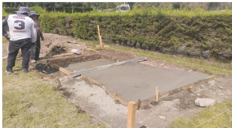
*Nota.* Fundición de la losa de cimentación en toda el área de implantación del modelo. Autoría propia
