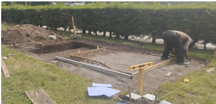
*Nota.* La fotografía muestra la colocación de la malla electrosoldada y encofrado para la losa de cimentación. Autoría propia
