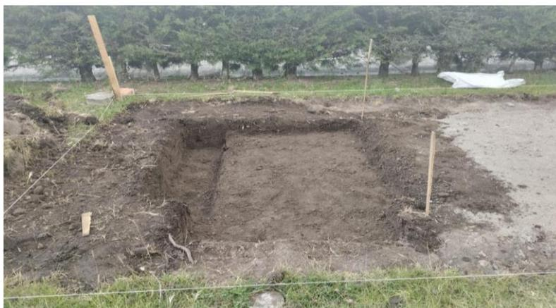
*Nota.* En la fotografía se observa la excavación para la losa de zampeado y el tanque recolector. Autoría propia
