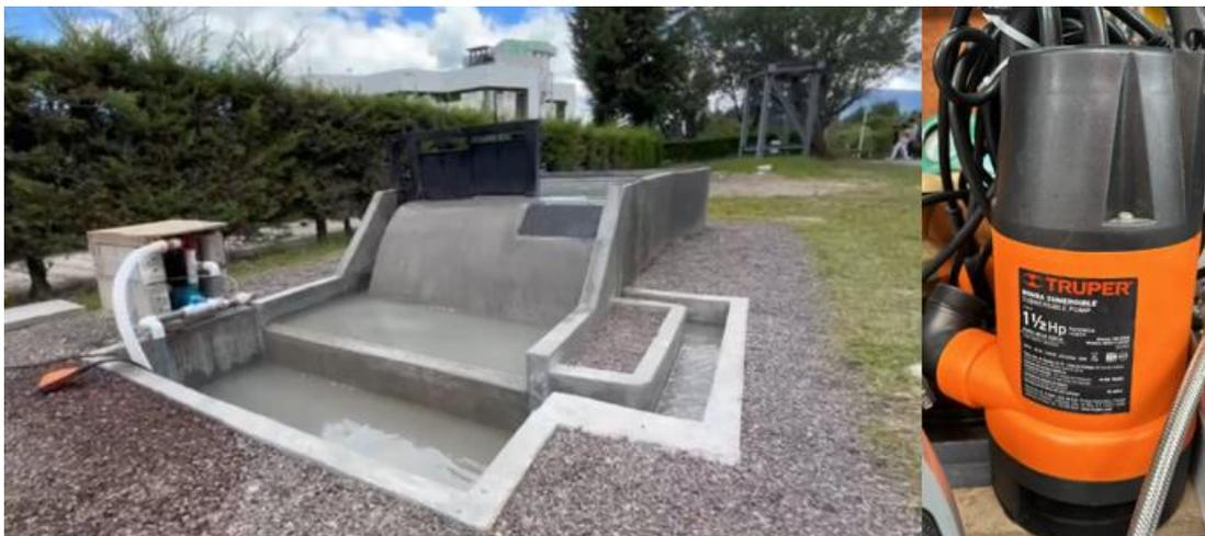
*Nota.* Colocación e instalación del sistema de alimentación y recirculación del modelo a través de una bomba sumergible y tubería que se extiende desde el tanque aguas abajo hacia el tanque aguas arriba. Autoría propia
