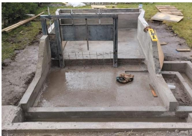
*Nota.* Construcción de muros de encauzamiento y colocación de la compuerta de lavado y compuertas para época de estiaje sobre el vertedero creager tipo WES. Autoría propia.
