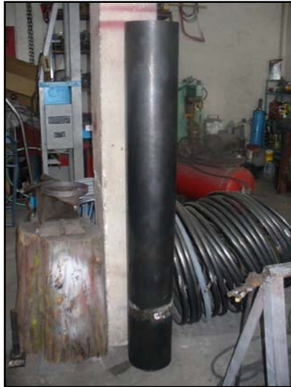
Figura 5. 26 Ducto de la Chimenea
