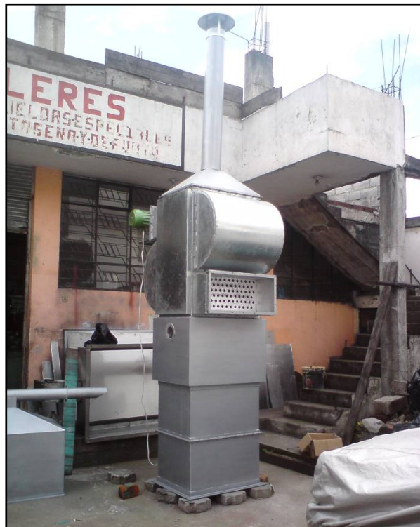
Figura 5. 45 Ensamble del Plenum y chimenea
