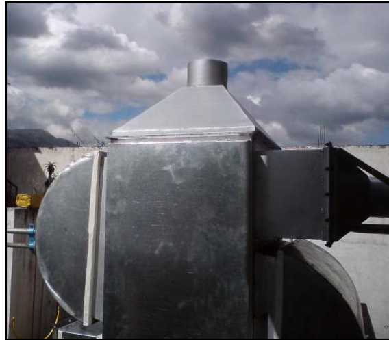
Figura 5. 44 Ensamble del Plenum, vista Frontal
