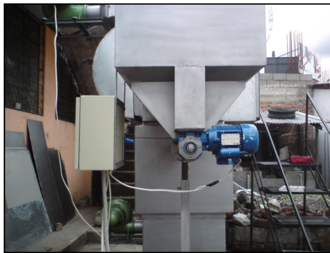
Figura 5. 48 Montaje de Motor reductor
