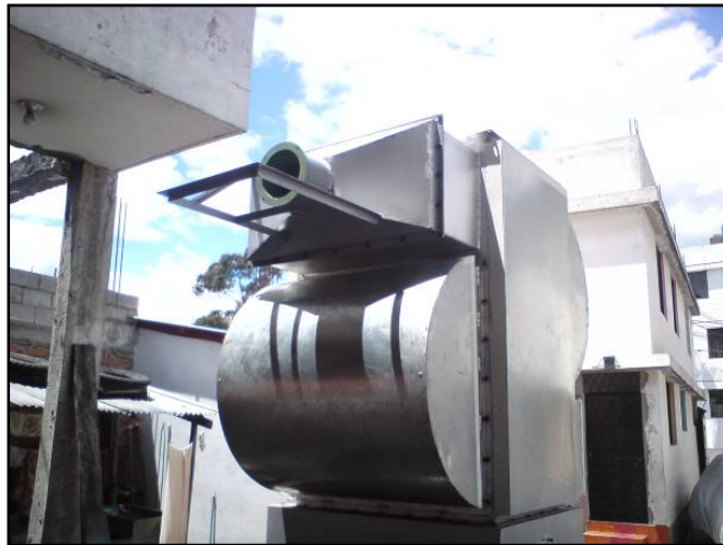
Figura 5. 42 Ensamble Ducto para venterol de 6", vista lateral
