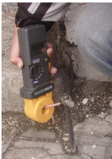
Figura 3.6. Equipo de medida para tomas de puesta a tierra.
