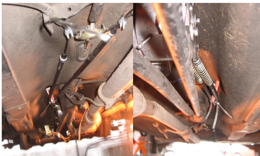
Figura 4.45 Sistema completo instalado el vehículo Fiat Mille 95.
