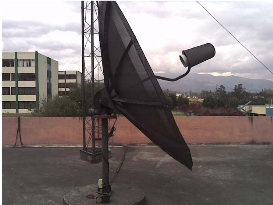
Figura. 5.1. Antena en 30 grados
