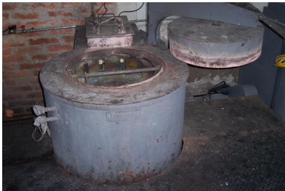
Figura 4.9.- Horno de precalentamiento
