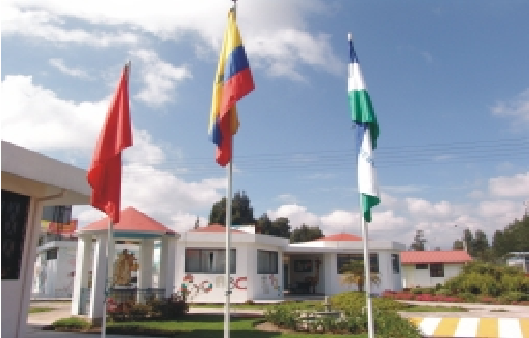
Instalaciones de la Fundación Virgen de la Merced - FUVIME
