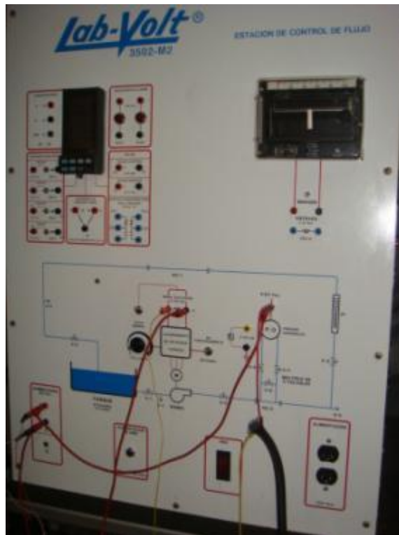
Figura 3.40. Conexión en la estación de flujo
