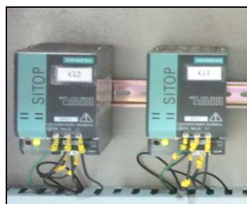
Figura 3.6 Fuentes de alimentación de los dispositivos de control.
