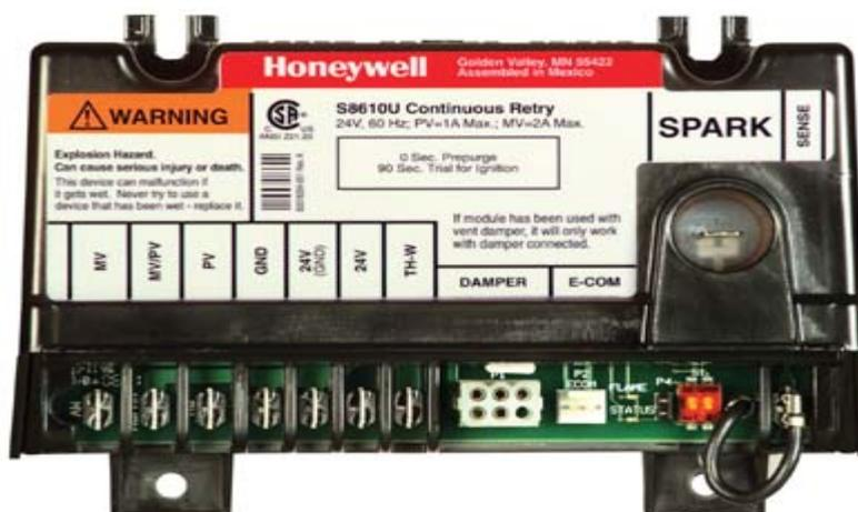
Figura 5.4.- Módulo de control de encendido
