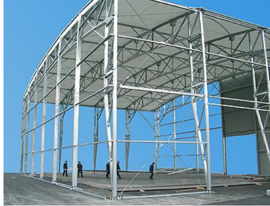
Figura 1.19 Estructura de Acero Ligera.
