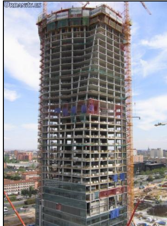
Figura 1.18 Estructura de Acero Pesada, Torres Madrid Arena.
