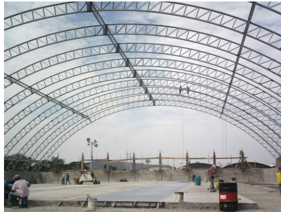
Figura 1.20 Cercha para cubierta FERMAGRI SA. http://metaes.com/estructuras-metalicas
