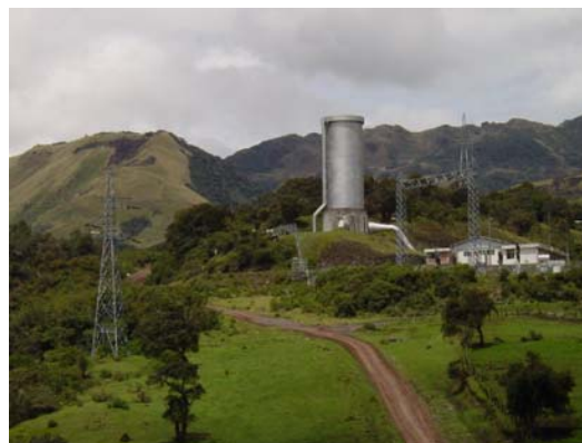
Figura 1. 5. Estación Booster II
