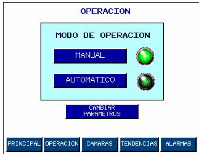
Figura 3. 18. Pantalla de operación de Terminal de operador
