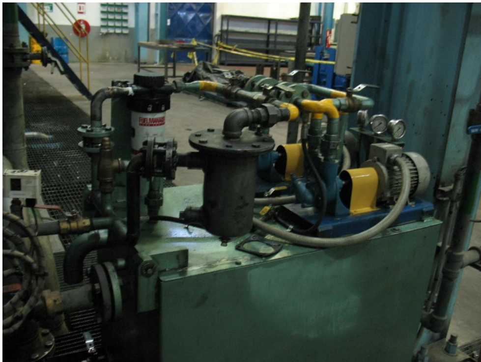
Figura. 2.9. Bombas de lubricación de balancines
