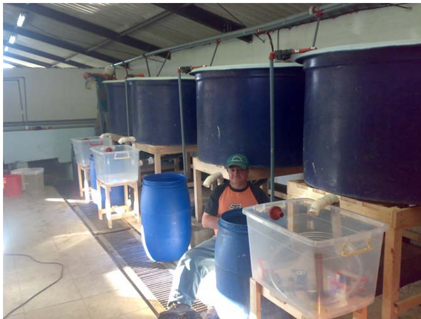
Figura 5.5 Construcción de Tanques de Producción IASA I
