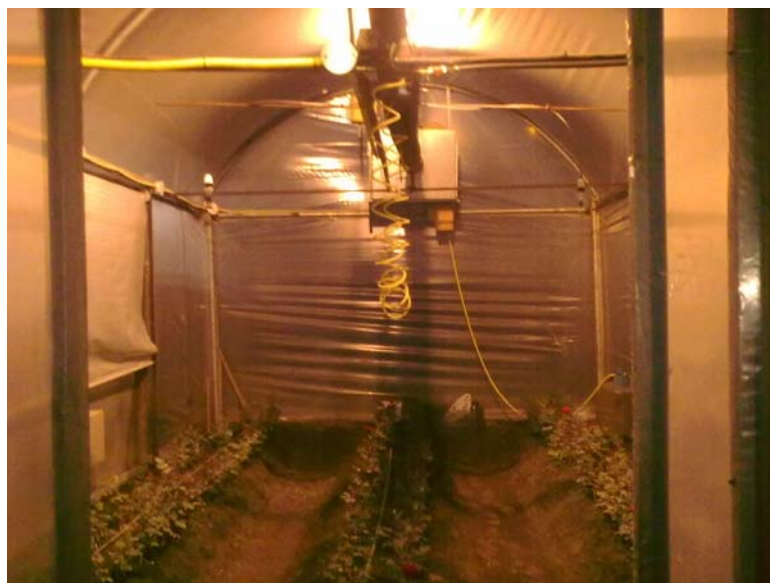
Figura 3.40: Prueba del sistema de iluminación
