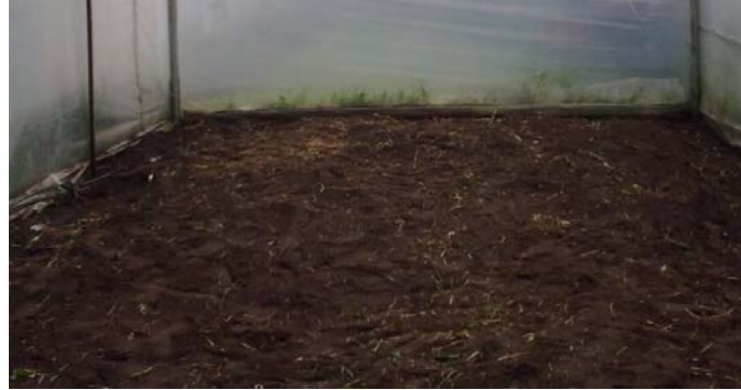
Figura 3.20: Preparación del Terreno
