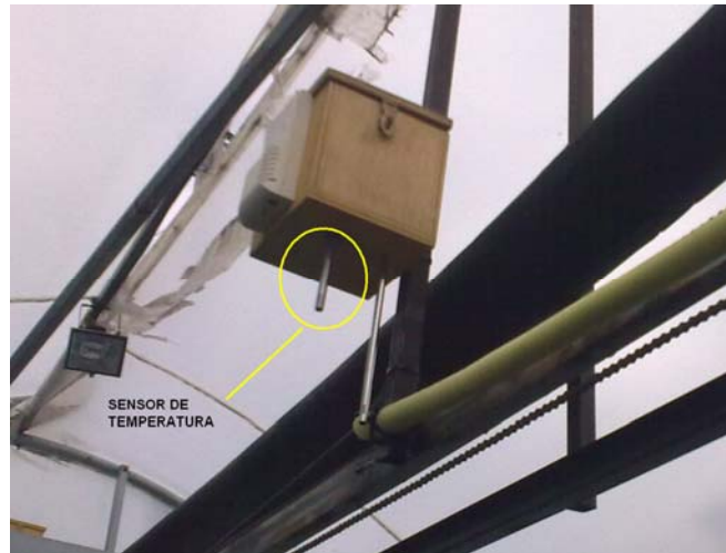
Figura 2.32: Ubicación del sensor de temperatura
