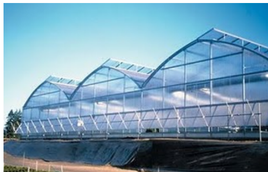
Figura 1.5: Invernadero de Capilla
