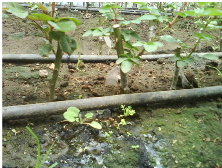
Figura 3.35: Prueba del riego por goteo
