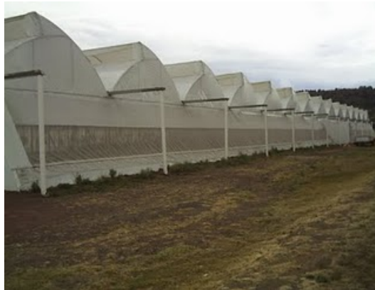
Figura 1.3: Invernadero en Raspa y Amagado.
