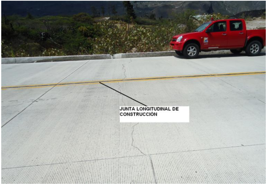
Fotografía 2: Junta Longitudinal de Construcción Carretera Cumbe – Oña
