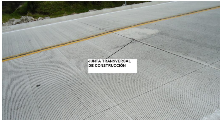
Fotografía 1: Junta Transversal de Construcción Carretera Cumbe – Oña
