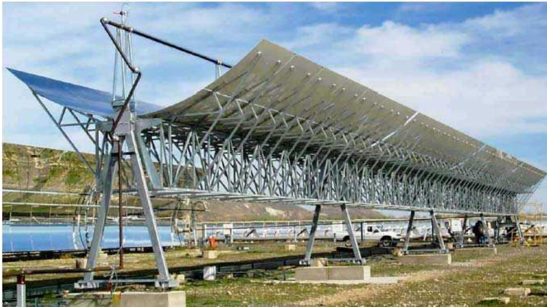
Figura 4.4 Estructura metálica - tipo espacial 12
