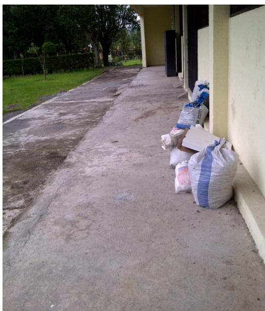
Fotografía. 2.5 Acumulación de material de despojo fuera de los laboratorios
