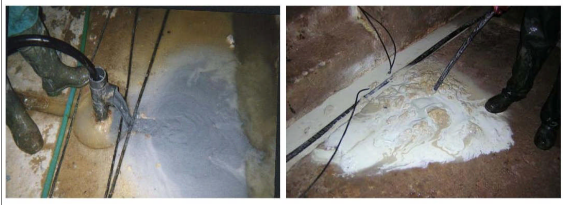
Figura 1. 34 Extracción de los detritus generados por la limpieza (Fuente HCC)
