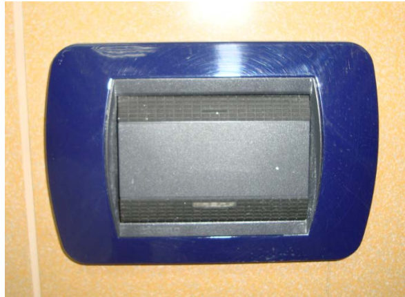
Figura 4.49. Instalación del Pulsador de Código Azul
