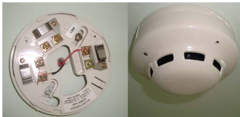
Figura 4.20. Instalación de Detectores
