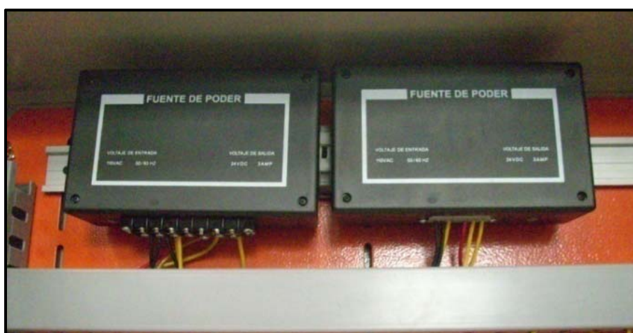
Figura. 6.6. Instalación de las fuentes de poder de 24 VDC
