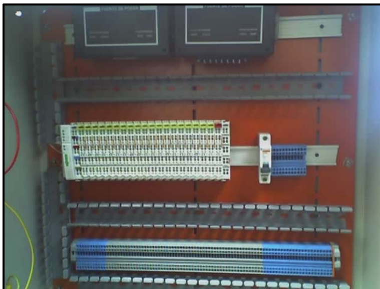
Figura. 6.7. Interior del tablero ENV
